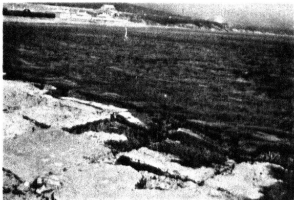
№ 11. Новороссійскъ. Видъ защитныхъ массивовъ, уложенныхъ на вѣшной бермѣ Восточнаго мола.
