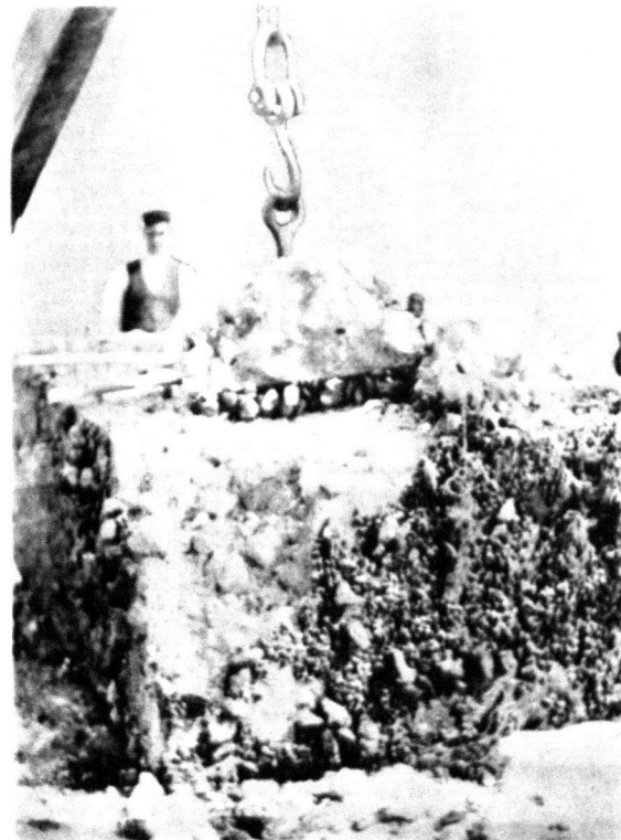
№ 17. Одесса. Щебеночно-бетонный массив на рас- творъ изъ римской пуцолланы сь известью, работы 1868-69 г. Вынуть изъ воды в 1904 г. сь внутрен- него откоса рейдовой части Карантиннаго мола.
