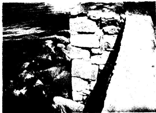
№ 7. Петровскъ. Видь полуразрушенной части охранной стѣнки на Южномъ молѣ.
