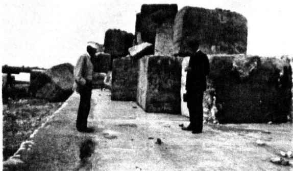
№ 9. Поти. Видъ бетонныхъ массивовъ работы 1874-78 г. на растворѣ изъ Тейльской извести.
