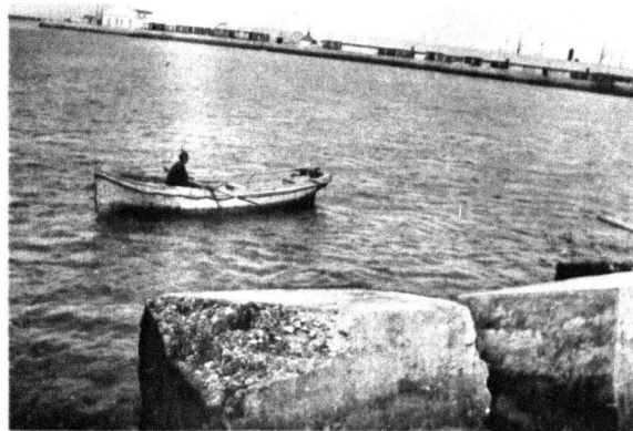
№ 10. Поти. Видъ бетонныхъ массивовъ работы 1874-78 г., на растворѣ изъ Тейльской извести.
