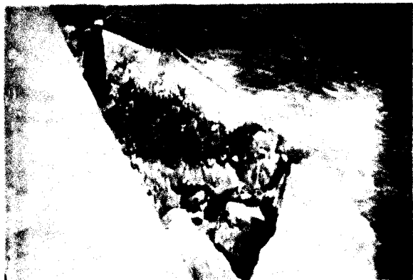
№ 5. Поти. Видь наброски изъ защитныхъ массивовъ съ вѣшной стороны волнолома.
